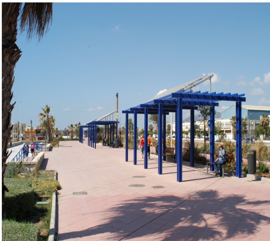
Pérgolas con instalación fotovoltaica (10kW) Pº Marítimo Antonio Banderas
